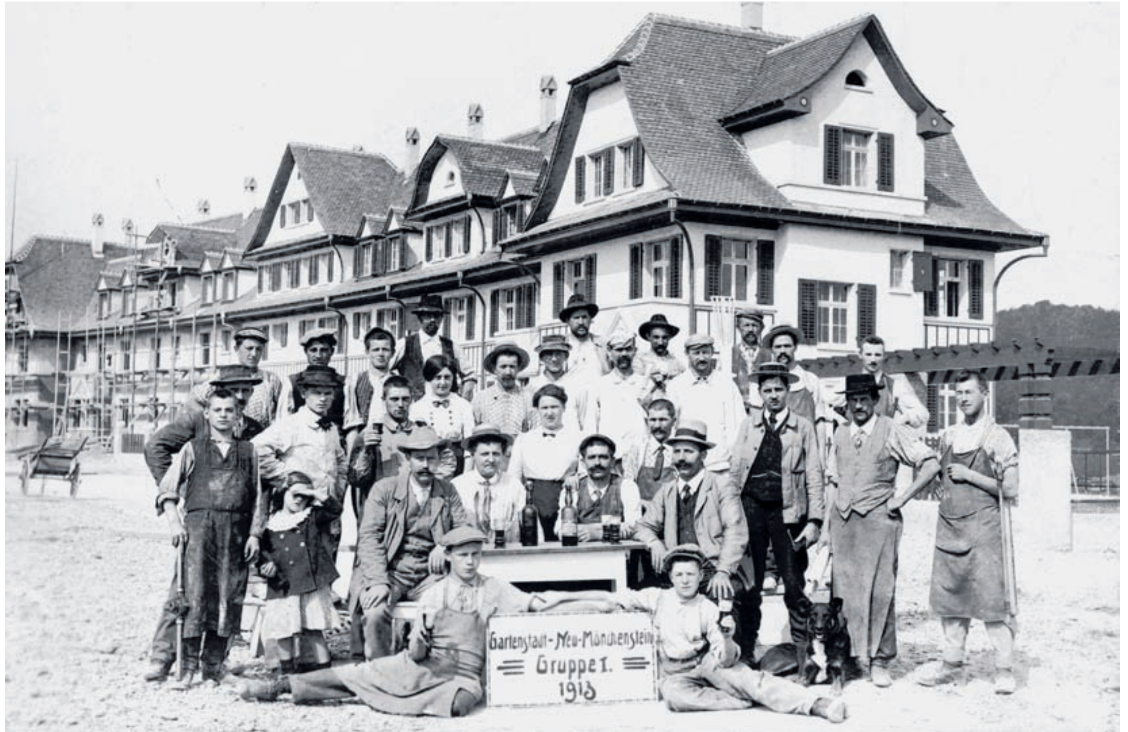
Pioniere in Feierlaune. Derweil die Häuser noch in den Baugerüsten auf den letzten Schliff warten, stossen die künftigen Bewohner im Sommer 1913 auf ihre Wohnräume an. Foto Bürgergemeinde Münchenstein
