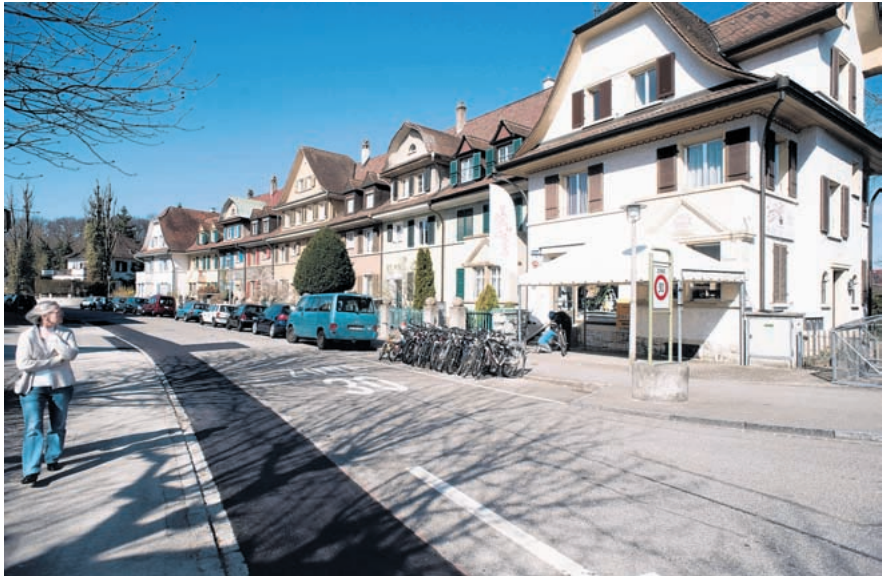
Späte Anerkennung. 100 Jahre nach dem ersten Spatenstich soll die Gartenstadt in Münchenstein unter Denkmalschutz gestellt werden. Foto Roland Schmid
