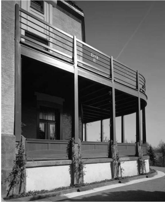
Villa Esche, Balkon an der Südostecke
